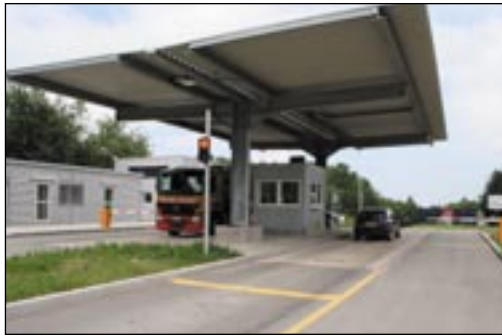
Eingangsbereich der Müllumladestation Talheim
